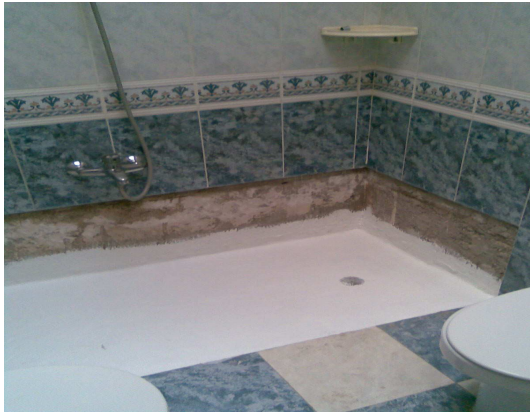
Imagen 5 Adaptación de Baño: Eliminación de bañera.
