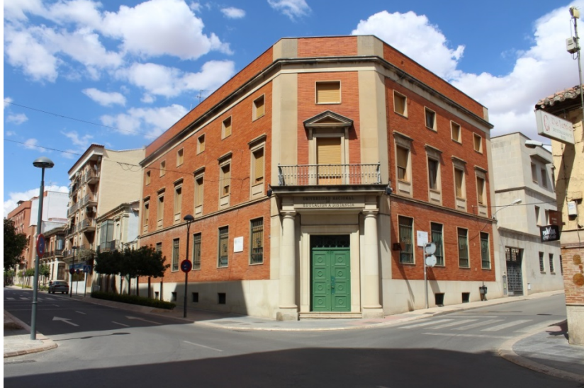
Foto 1: Fachada del Centro Asociado UNED. Valdepeñas
