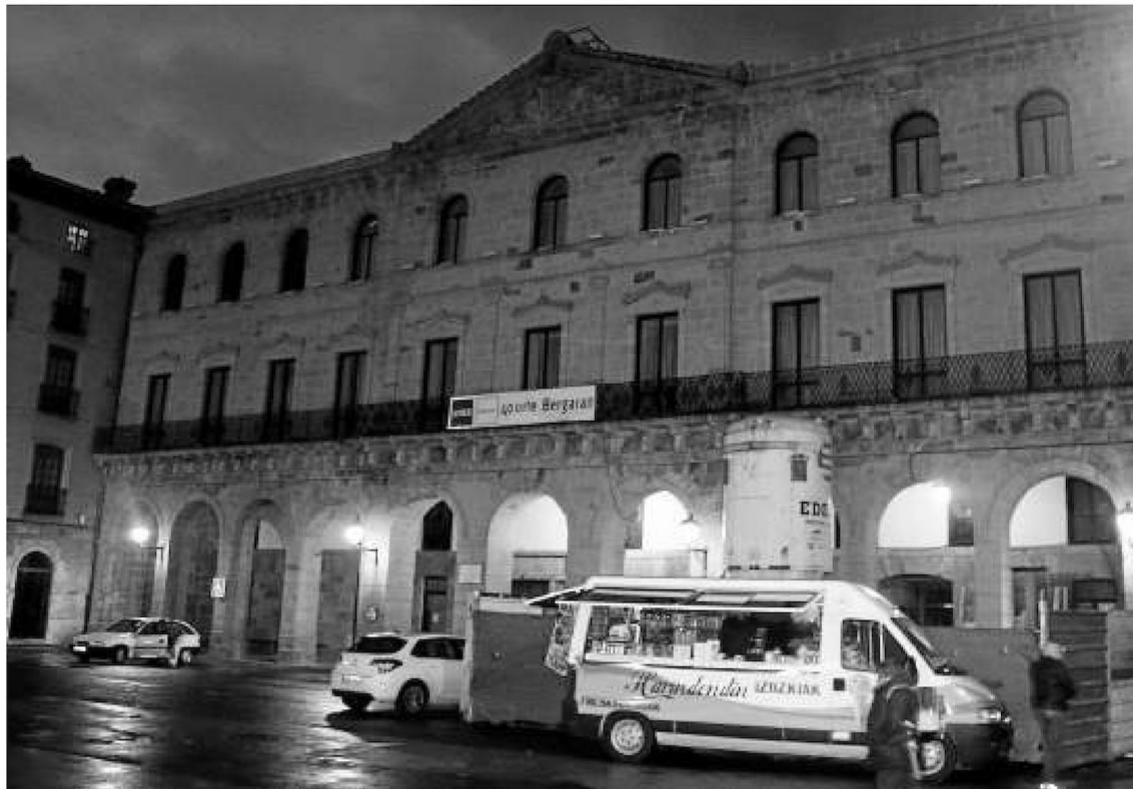
Imagen de la fachada principal del Real Seminario, donde se ubica la actividad docente del centro asociado Uned-Bergara. Foto: A.D.
